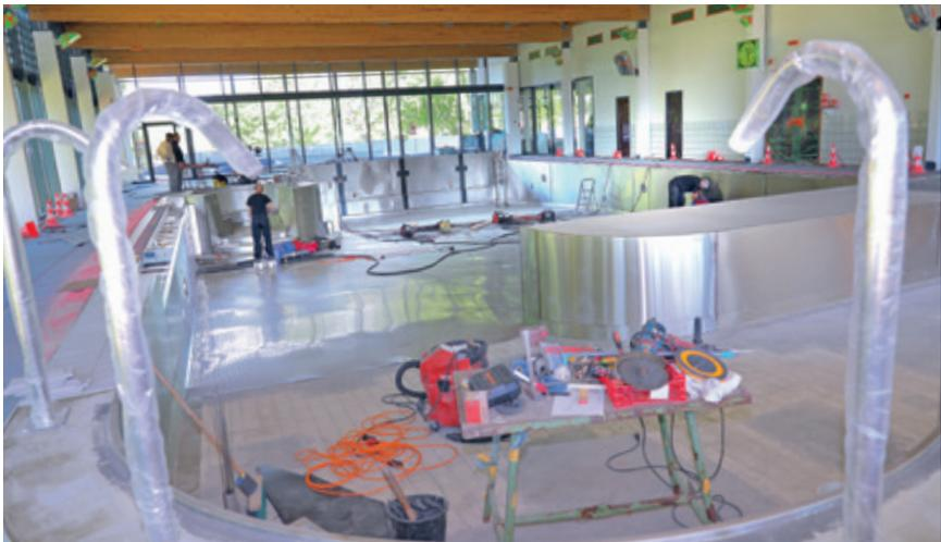
L'inox vient se substituer au carrelage pour assurer l'étanchéité du bassin
