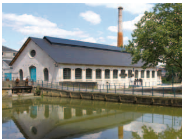
La rénovation de la Patinoire à Châtellerauld
