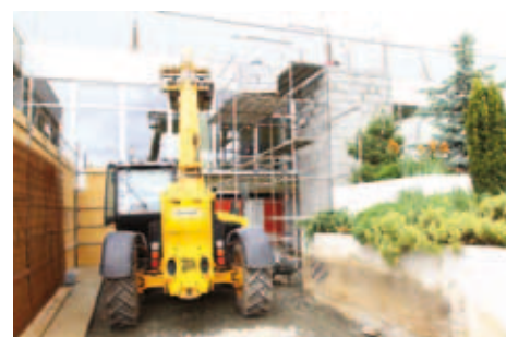
Les travaux de la salle Omnisports à Châtellerauld
