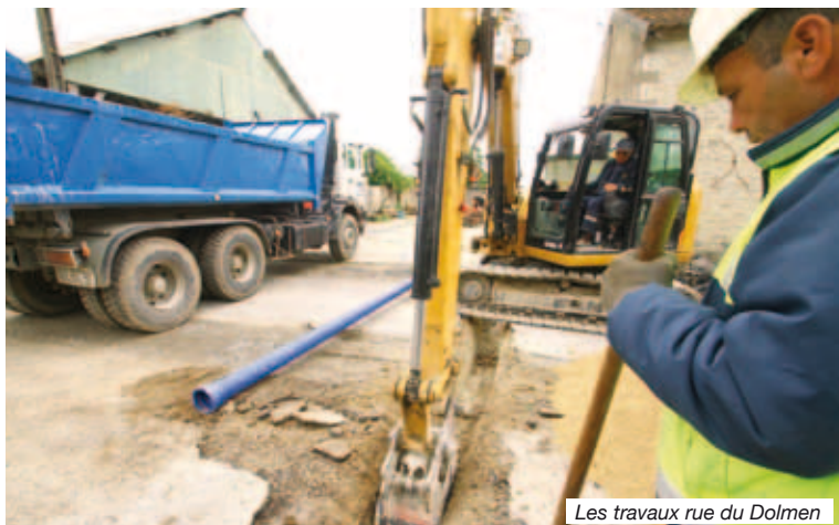
Les travaux rue du Dolmen
