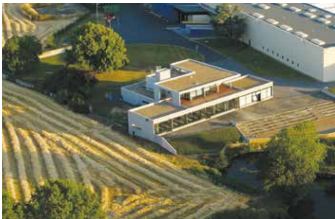
Le stockage de l'usine Fenwick de Cenon-sur-Vienne a été relevé en 1995.
