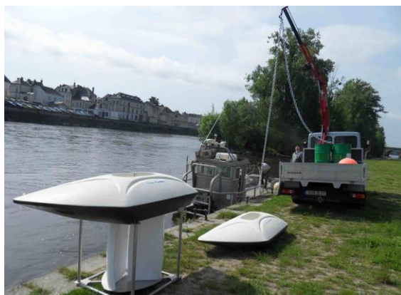
Installation des pico-hydroliennes au mois de mai 2015
